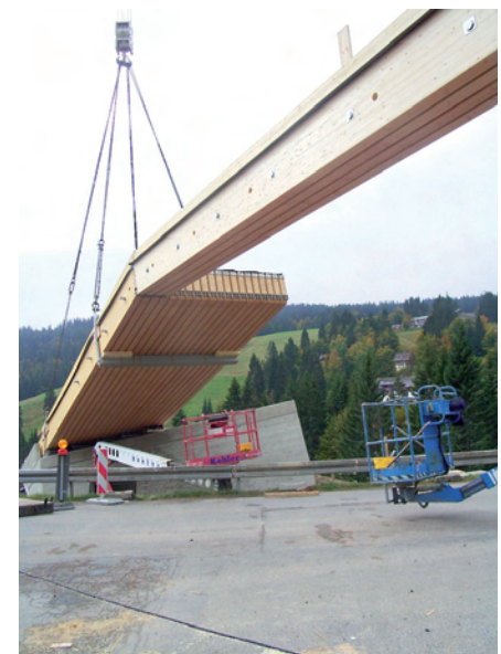
Bild 9 Die erste talseitige Hälfte des Brückenabschnitts wurde „in Eins“ eingehoben und „kranhängend“ gehalten bis der bergseitige Abschnitt aus „Viererpacks“ eingefügt war.
