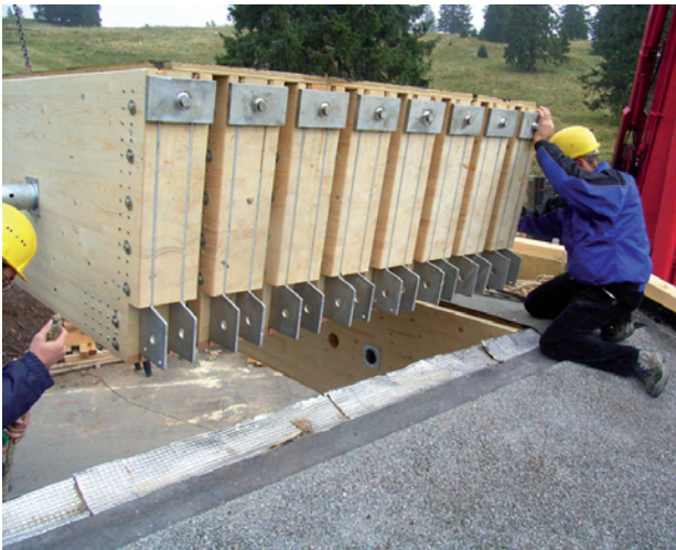
Bild 6 Klassischer Stahlbau-Vollstoß beim „Einfahren“, ...
