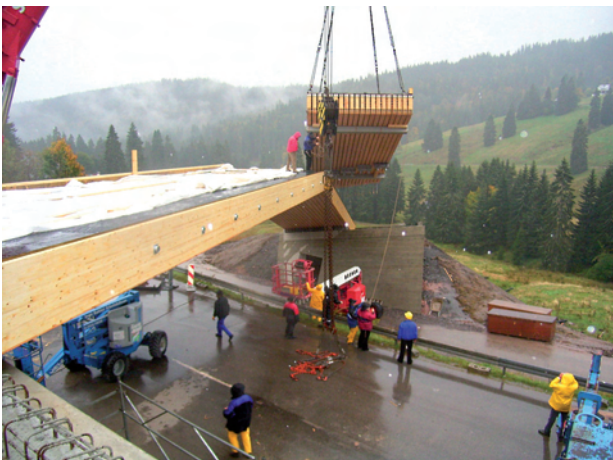
Bild 8 Die zweite Hälfte des talseitigen Abschnittes schwebt an ihren PLATZ.
