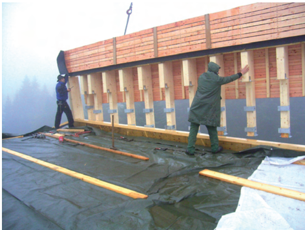
Bild 10 Das Geländer war abschnittsweise soweit möglich werkseitig vorgefertigt
