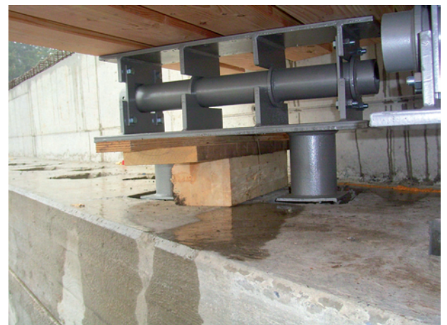
Bild 4 Klassisches Rollenlager im Montagezustand, die Aufständerungen wurden hernach mit Beton ausgegossen und so mit der Auflagerbank verbunden, deswegen noch die hölzernen Unterlagen. Vorbildlich der Raum für Inspektionen und Revisionen.
