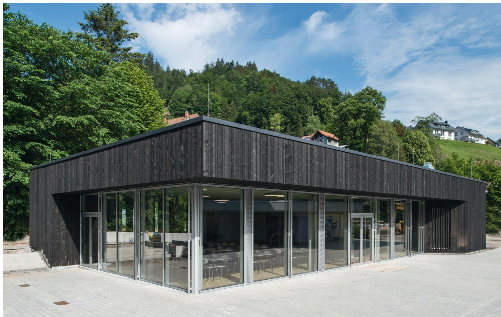
Der Neubau der Mensa, die als eigenständiges Gebäude das Areal der Gemeinschaftsschule Oberes Wiesental in Todtnau ergänzt. FOTOS: STADT TODTNAU
